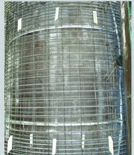
Ein stählernes Korsett: der maßgeschneiderte Bewehrungskorb.
