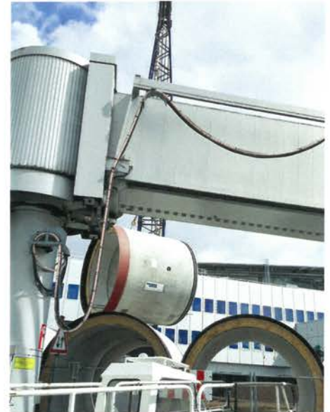
Auch eine logistische Herausforderung: das „Einfädeln“ eines 22 Tonnen schweren Vortriebsrohres in die Baugrube
