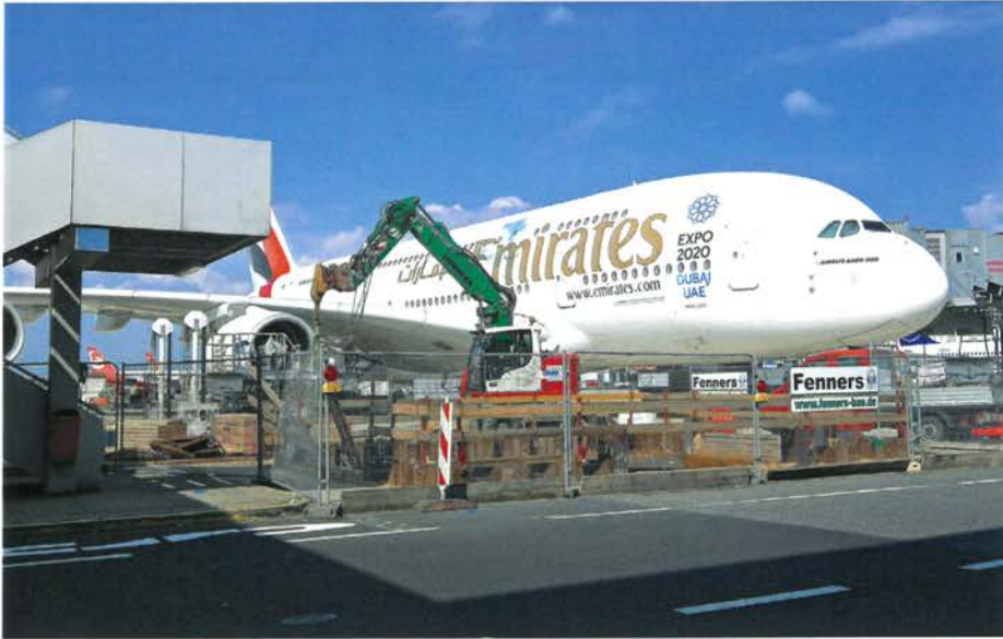
Selbst Großflugzeuge wie hier ein A 380 konnten in unmittelbarer Nähe einer Schachtbaustelle ohne Beeinträchtigung abgefertigt werden.
