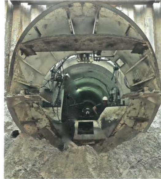
Blick aus der Vortriebsmaschine in den Infrastrukturkanal
