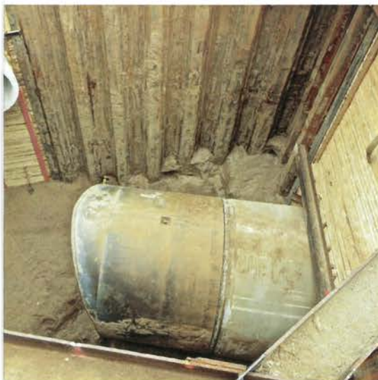
Vortriebsmaschine in der Zielbaugrube. Im Bild oben: Einfahröffnung für einen Vortrieb DN 1000 zum Einbau von Kabelschutzrohren mit einem Höhenversatz von 3,40 m oberhalb der Hauptvortriebssohle
