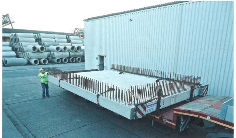
Anlieferung eines Schachtelements mit im Betonwerk integrierten Einbauteilen
