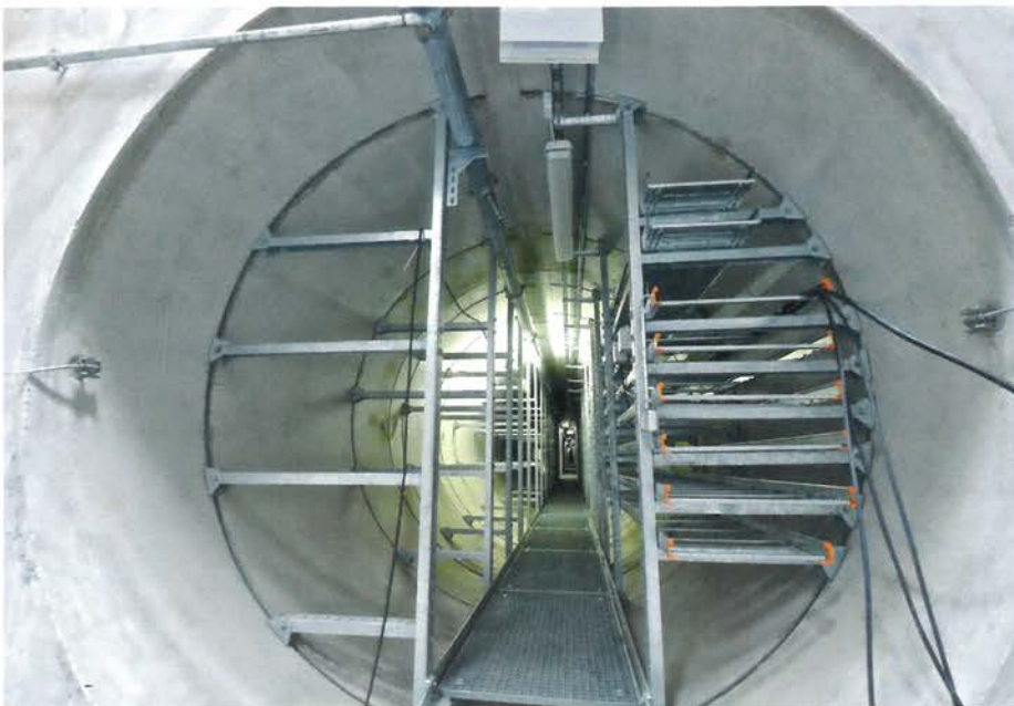
Der begehbare Infrastrukturkanal, ausgestattet mit einem flexiblen Montage- und Tragsystem vor der Belegung
