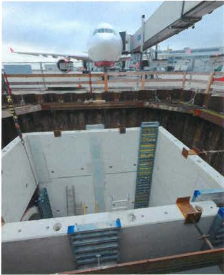
Ortbeton-Ergänzung der Fertigteile im Baufeld
