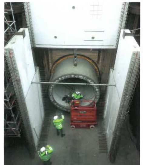
Zusammenfügen der bis zu 28 t schweren Wandelemente auf einer Stahlbeton-Bodenplatte. Im Bild oben links die Öffnung für die Durchführung der Leerrohre
