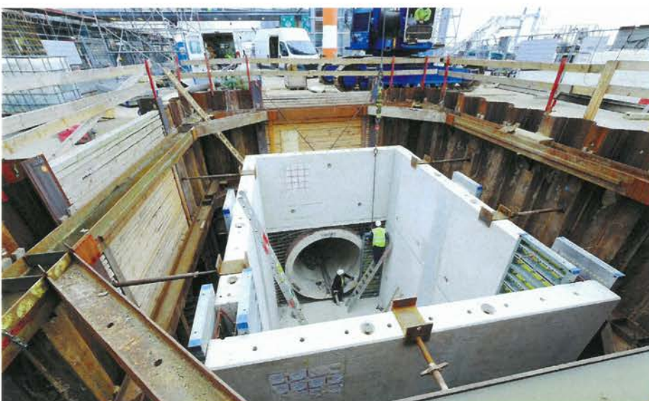
Erstmalig wurde ein Fertigteil-schacht dieser Dimension und einem Gesamtgewicht von 120 Tonnen mit Einzelelementen auf der Baustelle montiert.
