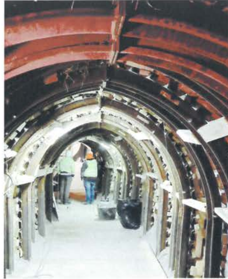
Blick in den Stollen mit biegesteifem Stahlverzug
