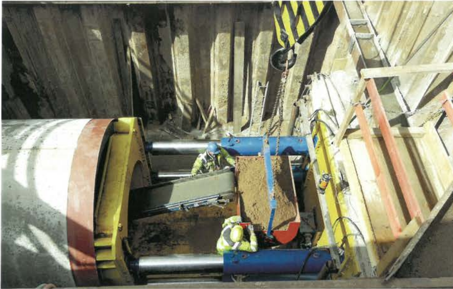
Bodenförderung aus Vortriebsstrecke und Baugrube über Förderband in eine Lore
